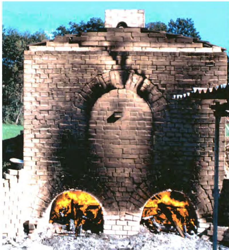
Abbildung 7: Der Ofen des Backsteinexperiments von St. Urban wurde 1997 speziell nach den Erkenntnissen aus der Forschung aufgebaut und hat sich im Experiment bewährt.
